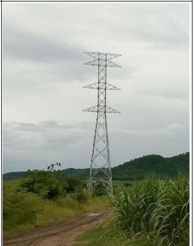
T-A171-1 Erection completd.
