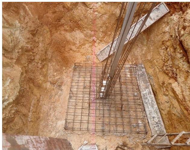
Rebar arragemante
