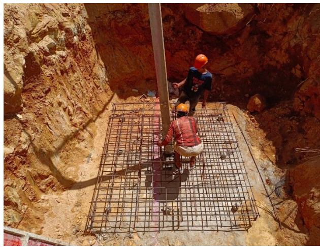
Rebar arragemante
