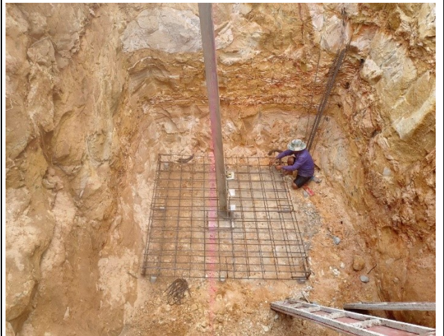
Rebar arragemante
